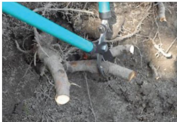
Ryc. Czyste cięcie jako najbardziej skuteczne zabezpieczenie korzeni drzew. Korzenie o średnicy powyżej 3 cm powinny być zachowane w wykopie (nie powinny być wycinane)
