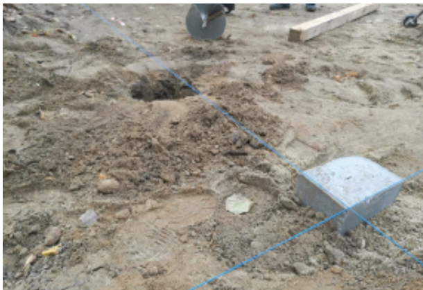
Ryc. Montaż punktowych fundamentów w SOD – podbudowy dla chodnika rampowego
