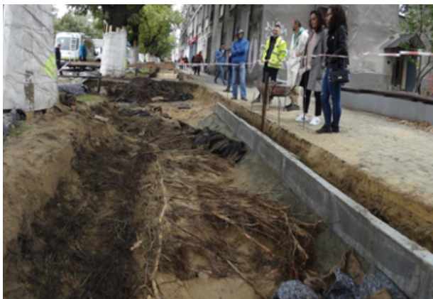
Ryc. Korytowanie pod nawierzchnię z podbudową z mieszanki kamienno-głebowej ułożonej w SOD na korzeniach drzew (warstwa nośna nawierzchni)
