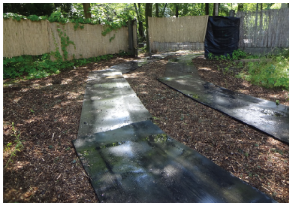
Ryc. 3 Przykład technologicznej drogi tymczasowej dla ruchu pojazdów w SOD a) schemat budowy, b) przykład - warstwa 30 cm kory lub zrębek przykryta gumowymi matami
