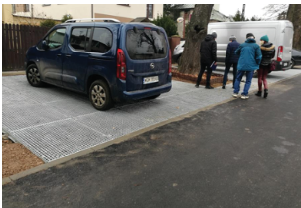
Ryc. Nawierzchnia rampowego chodnika ułożonego w SOD na punktowych fundamentach
