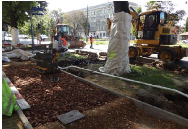
Ryc. Mieszanka kamienno – głebowa ułożona w SOD na korzeniach jako warstwa nośna nawierzchni
