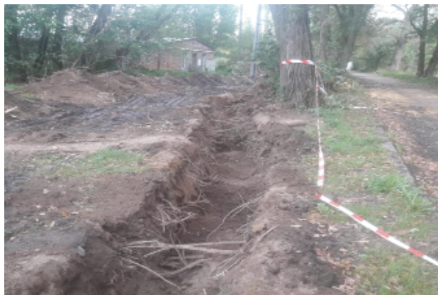
Ryc. 4 Przykład wykonania prac ułożenia instalacji bez ochrony drzew w SOD; drzewo ma uszkodzone korzenie - stanowi realne zagrożenie. Drzewo utraciło również swoją wartość – nie zachowa żywotności.
