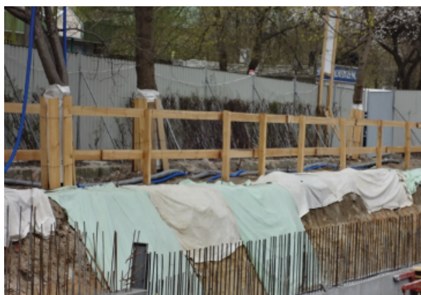
Ryc. 2 Ochronny ekran korzeniowy w SOD obejmuje zabezpieczenie ścian wykopu grubą geowłókniną oraz w przypadku wykonywania prac w sezonie wegetacyjnym rozłożenie linii kroplującej.
