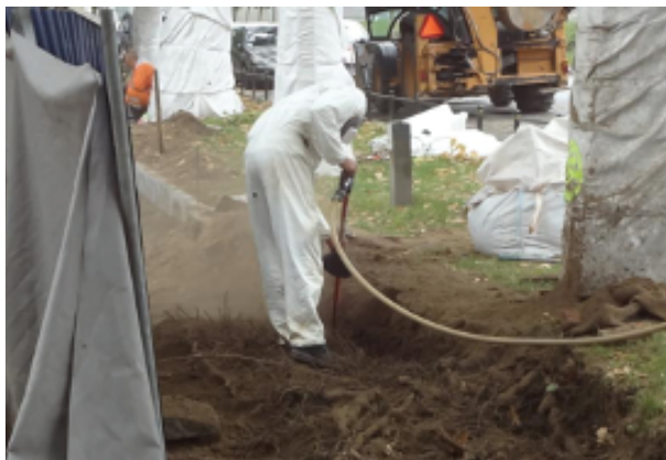
Ryc. Korytowanie pod nawierzchnią lub wykonanie wykopu pod korzeniami dla ułożenia instalacji
